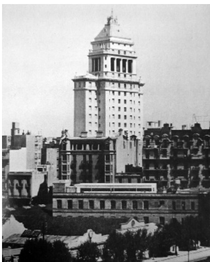
Figura 2e. Edificio Mihanovich. Fuente: Revista de Arquitectura n° 101, SCA, mayo 1929.
