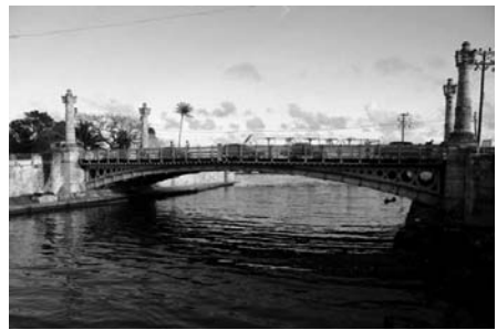
Figura 25: Puente de "La Concordia" sobre el río Yumuri (1878), del arquitecto español radicado en Matanzas Pedro Celestino del Pandal. Fuente: fotografía de Julio Larramendi.
