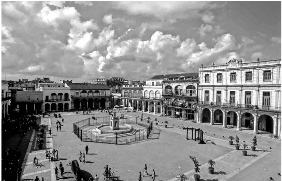
Figura 7: Plaza Vieja, antes Nueva. Fuente: fotografía de Julio Larramendi. En el siglo XVIII, en la plaza Vieja, entonces Nueva, se sustituyeron las viviendas iniciales por elegantes mansiones de dos pisos con entresuelos que retomaron la propuesta renacentista de las logias en el piso noble y portales en los bajos sobre arcos y columnas florentinas, con patios claustrados, solución que se extendió a todo el perímetro de esta singular plaza, sin dudas una de las más notables de Hispanoamérica por la unidad urbano-arquitectónica de su concepción.
