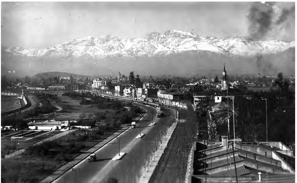
Figura 2: Vista avenida Providencia y canalización de río Mapocho, 1935 (foto de Enrique Mora). Fuente: Archivo del Centro Nacional de Patrimonio Fotográfico.
