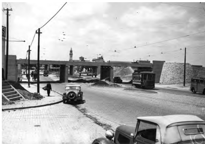
Figura 7: Avenida General Paz, enero de 1940. Aún en obra, en un tramo cerca de la intersección de la avenida Rivadavia. Fuente: Archivo diario La Prensa .
