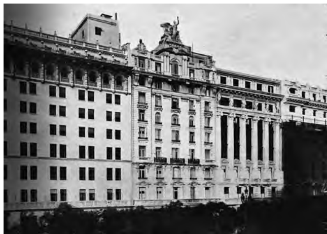
Figura 16: Edificio La Patagonia en diálogo con los edificios linderos, Av. Roque Sáenz Peña 541 y San Martín 50, ciudad de Buenos Aires (1925). Fuente: Revista de arquitectura , 1927, 23.
