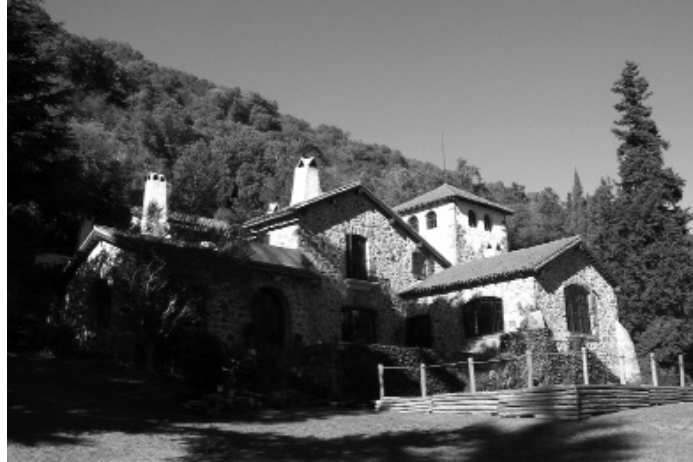
Figura 6: Toledo. Exterior. Actualmente funciona como hostel. Fuente: Fotografía de la autora.
