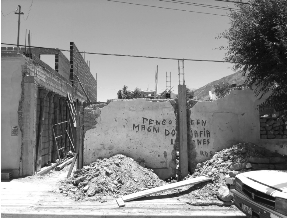
Figura 5: Construcción en Maimará. Fuente: fotografía de autores (2020).
