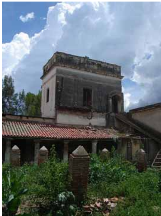
Imagen N° 3: Vista del segundo piso de la casa
