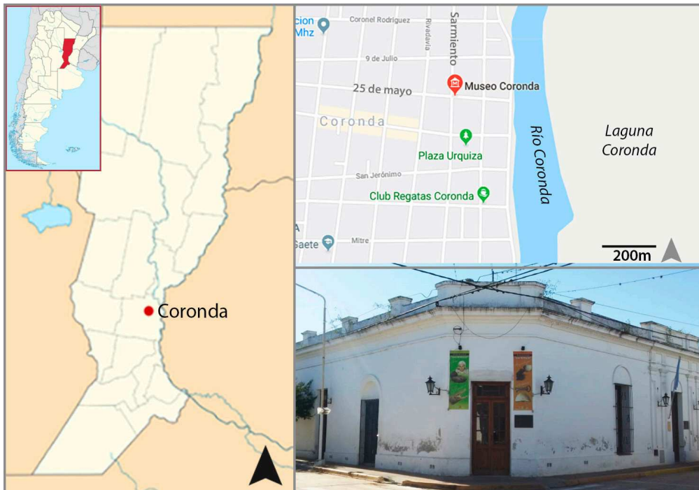
Figura 1. Ubicación y fachada actual del Museo Municipal José Manuel Maciel de la ciudad de Coronda, provincia de Santa Fe.
