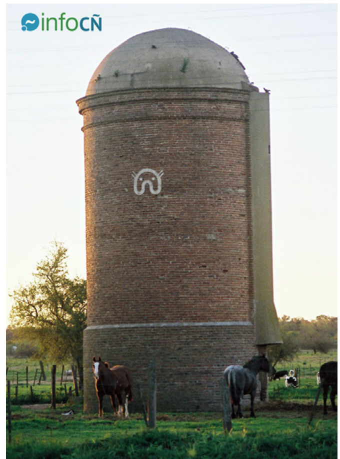
Figura 2. Silo aéreo de ladrillos (1889), La Martona, Vicente Casares, Buenos Aires (www.infocanuelas.com)
