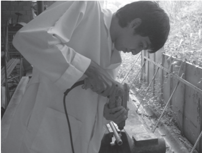
FIGURA 1. Apertura de orificios en los pozos
