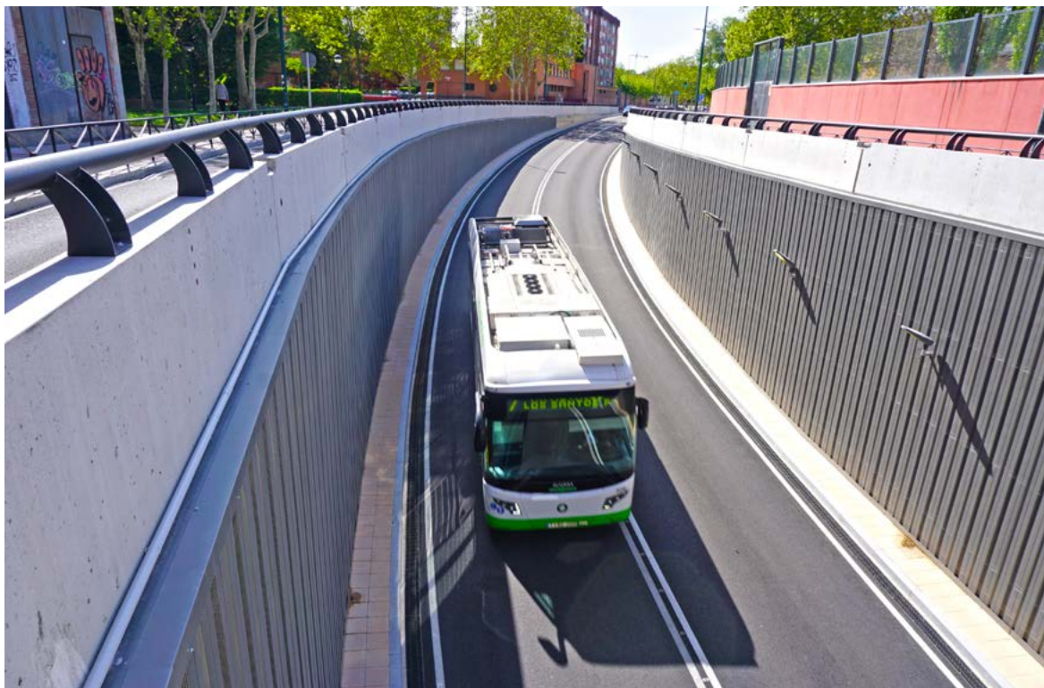
Figura 7. Paso inferior, rodado y peatonal, entre calles de la Noche Vieja y Andrómeda, ejecutado (registro propio, mayo de 2022)
