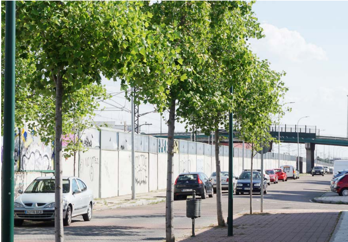
Figura 10. Muro suroeste y viaducto de Daniel del Olmo (registro propio, mayo de 2022)
