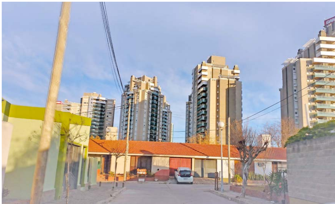
Figura 4. Localización de los emprendimientos inmobiliarios, y la transformación en el corredor Colón entre 2007-2020. Elaboración propia, 2022
