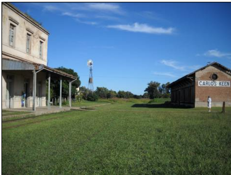
Figura 8: Estación de ferrocarril de Carlos Keen recuperada
