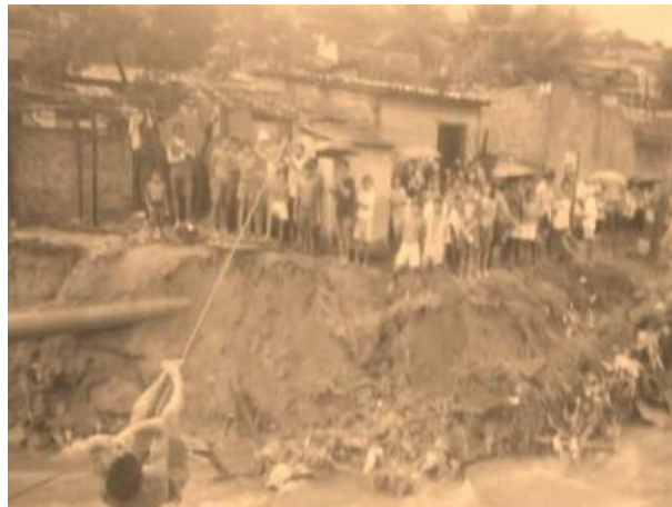
Figura 3: Fotografía de la comunidad durante la obra de edificación del canal
