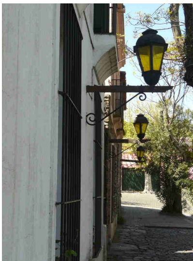
Fotografía 2: Luminaria urbanas instaladas por la intendencia de Colonia
