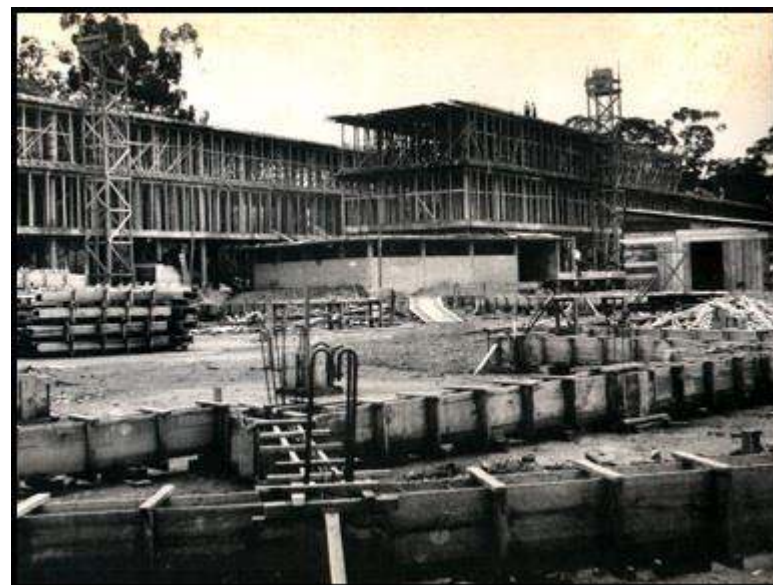
Imagem 1. Colégio em construção.
