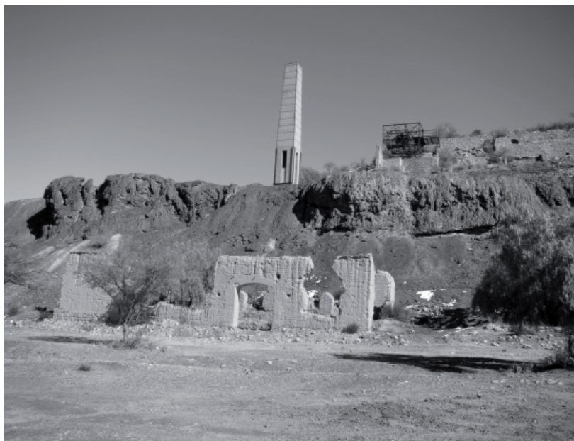
Figura 1. Ruinas del Ingenio Santa Florentina (Chilecito). Restos de construcciones, chimenea, escoriales y estación del cablecarril
