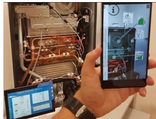
Figura 4. Visualização dos componentes da caldeira [9].
